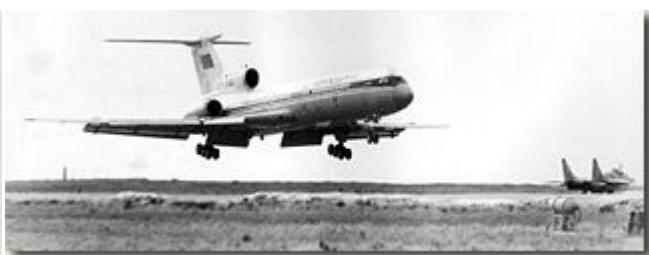
Посадка летающей лаборатории ЛЛ-083 (переоборудованный Ту-154Б) на ВПП аэродрома
