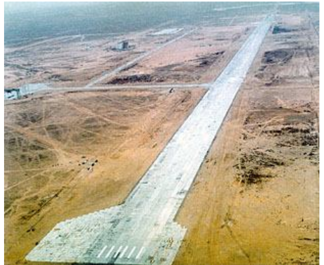
Вид с запада на ВПП строящегося посадочного комплекса с высоты птичьего полета. 1983-84 годы
